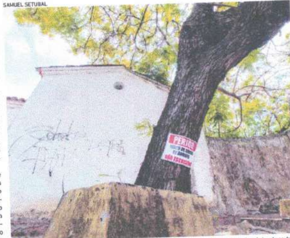
UMA PLACA de perigo foi colocada numa árvore na rua Barão do Rio Branco
